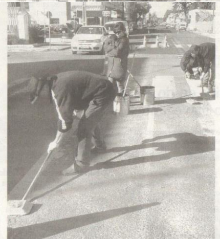
Operários usaram ferramentas para retirar os tachões
